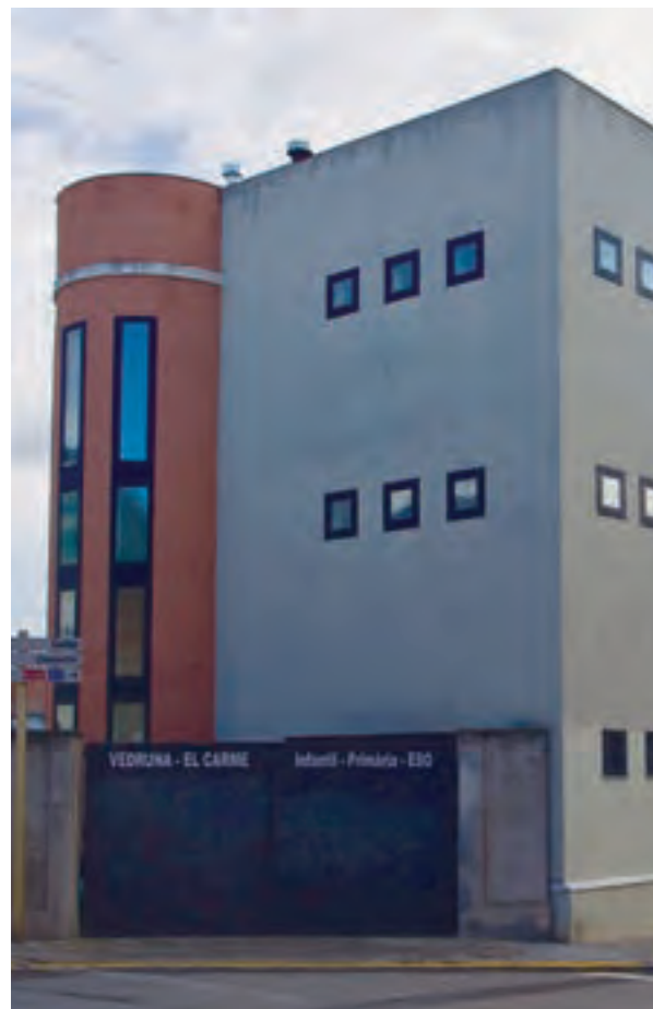
Edifici de Primària.
