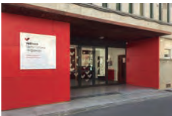
Remodelació façana. Any 2017.
